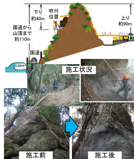
写真 開発した法面保護材の施工例 材料を工夫することで90mの山登りを含め700mの材料移送が可能。従来施工不可能な危険部を保護可能とし安全に寄与します
