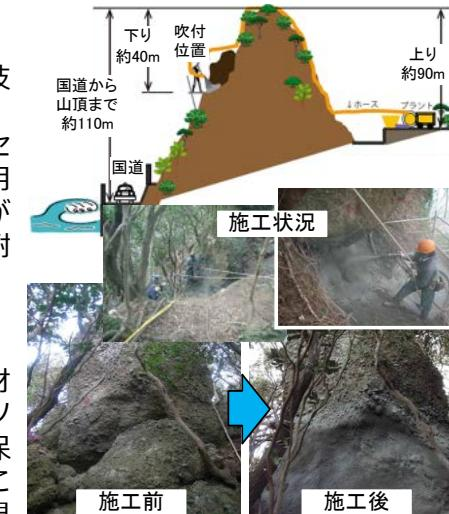
**写真 開発した法面保護材の施工例**
