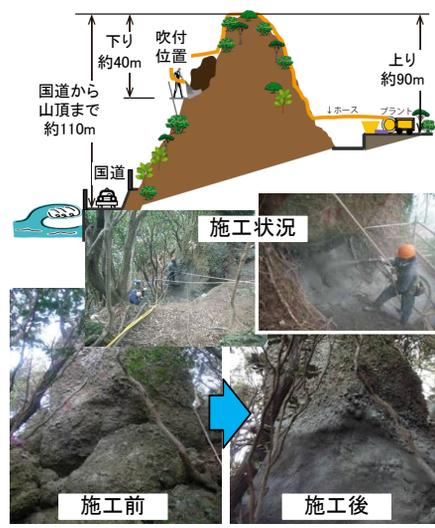
写真 開発した法面保護材の施工例
