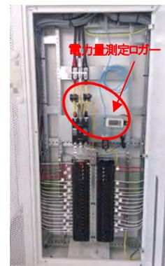
図11 建設棟3階西側分電盤電力消費量測定機器設置状況
