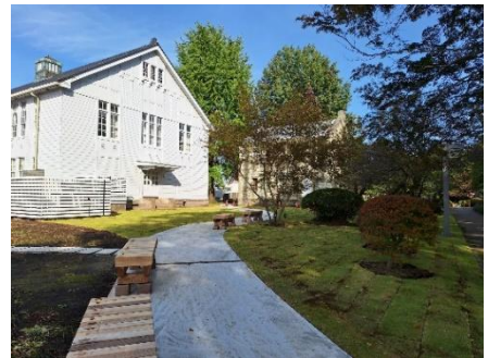
新たに設置した峰ヶ丘講堂園路と屋体ベンチ
