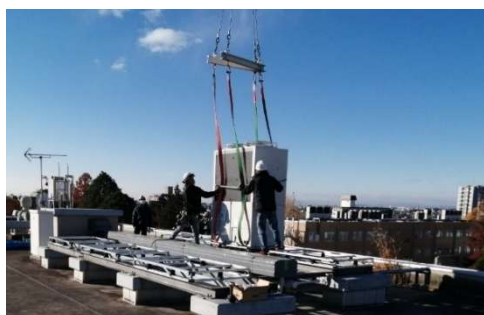
室外機 設置作業
