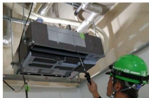
室内機 試験作業
