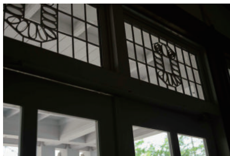
峰ヶ丘講堂エントランス飾り窓
