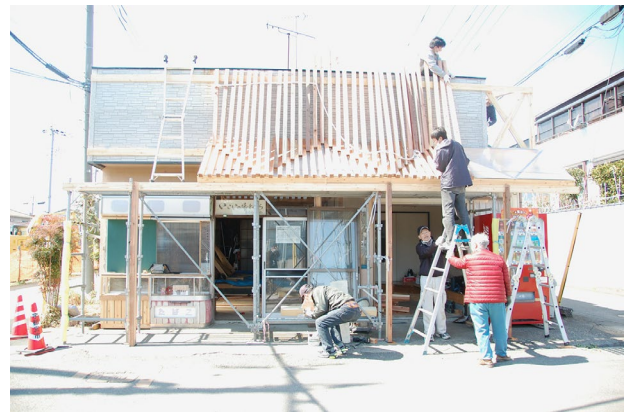
図6 ファサード改修
