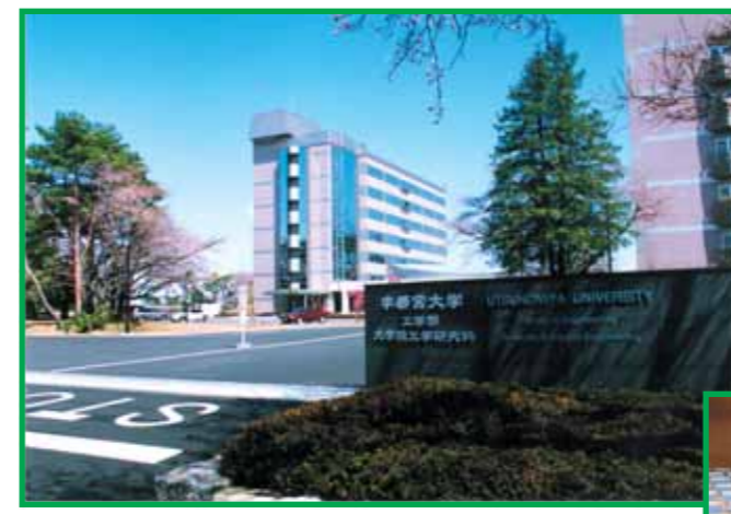
正門から見たエネルギー環境科学専攻棟
