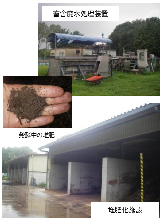
図4 機能を更新した廃水処理装置と堆肥化施設
