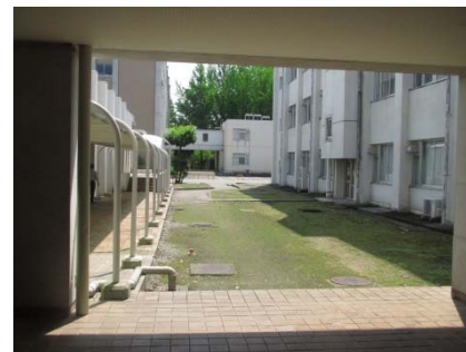
⑤5号棟中庭1：植栽がなく殺風景な印象。
