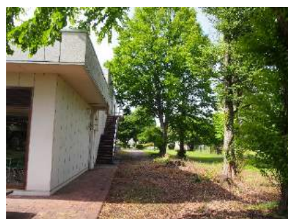
⑨ 石井会館東側：2階食堂に通じる外部階段があるが、通路部分が狭く、通行の誘導となるための改善の余地がある。
