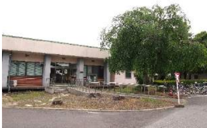
② 保健管理センター分室玄関：マツがあったが枯れのため伐採された。
