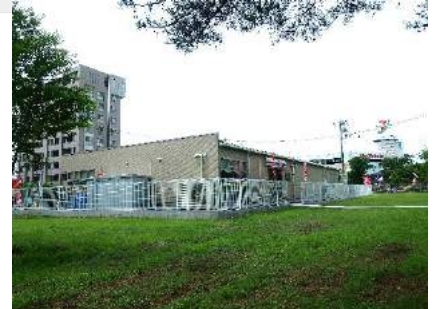
③ コンビニ：建設に伴い、若木は移植を行った。
