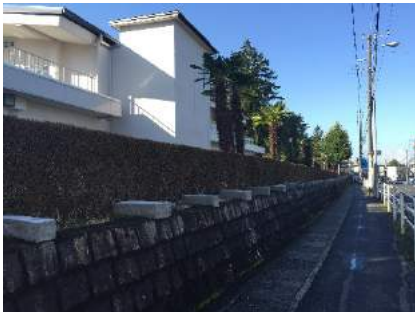
① 国道沿いのドウダンツツジ生垣：コンクリート柵が撤去され、道路沿いの緑視率が上がった。
