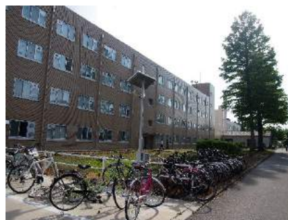
⑧ 4号館北側：写真奥に写っているラクウショウが並んで植樹されていたが、駐輪場のため伐採され、やや殺風景。
