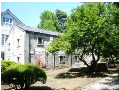
⑦ 旧図書館：保存と活用が検討されている。建築物と植物が一体となった景観ポイントがあるとよい。
