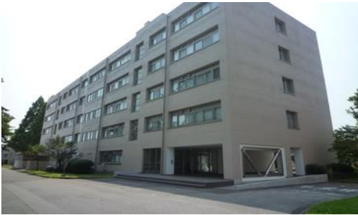
・工学部 8 号館（旧建設学科棟）
