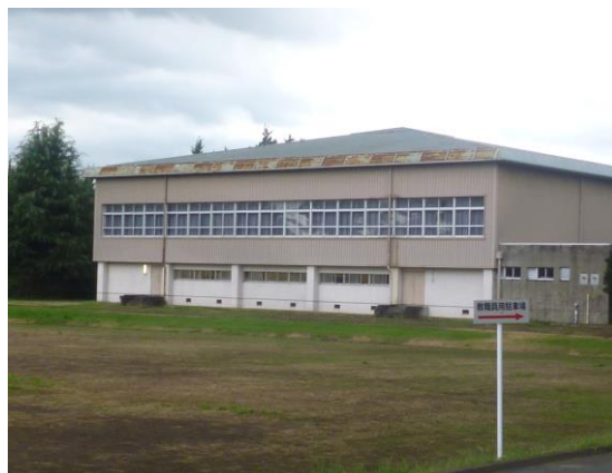
陽東体育館 (建物の老朽化が著しい)
