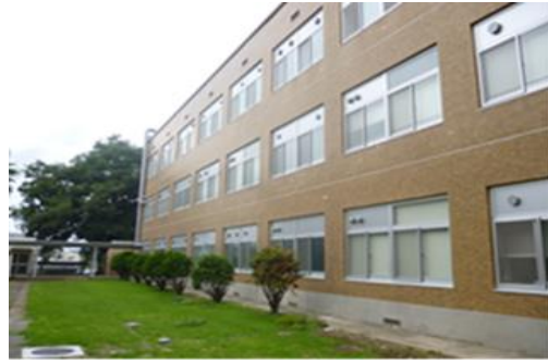
・峰町 2 号館（旧農学部 1 5 号館北棟）
