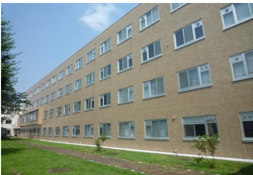
• 工学部 4 号館 (旧電気電子工学科棟)
