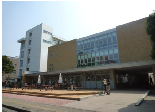
・峰町5号館（旧共通教育）B棟改修（その1）
