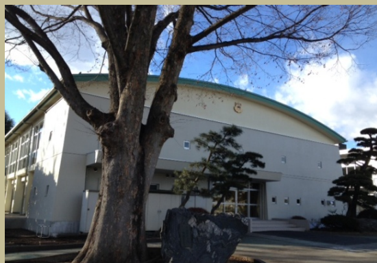
附属小学校屋内運動場 外観
