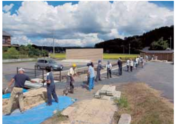
図4 手作業のリレーによる日干しレンガの運搬
