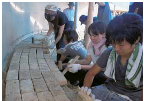
図5 日干しレンガの張り付け作業
