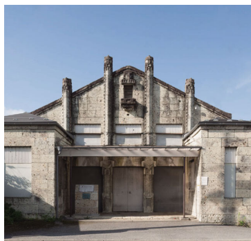
旧大谷公会堂 設計：更田時蔵 竣工：1926年
