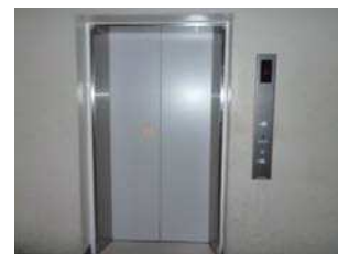
高効率型エレベーター設備
