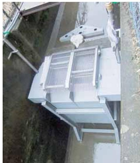
図6 マイクロ水力発電システム
