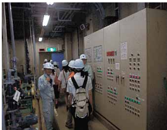
監査説明会での現場見学
